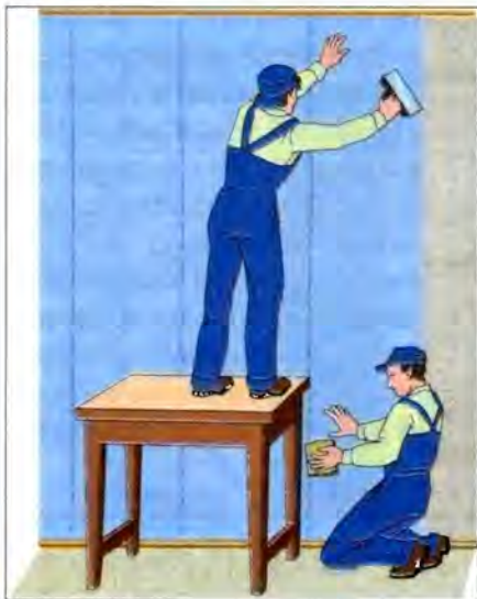
Рис. 101. Оклейка стен обоями
